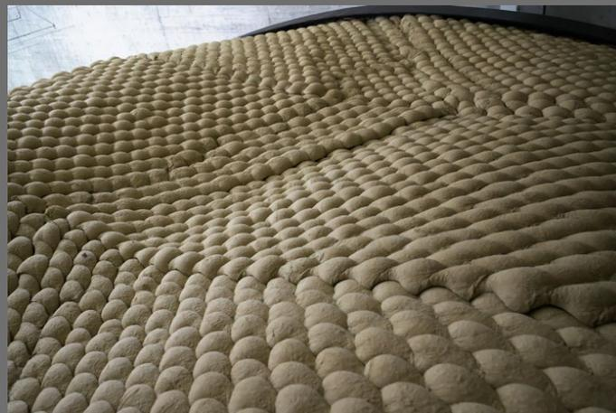
*Außergewöhnlich: Die sogenannte Clay Rotunda, ist eine freistehende, zylindrische Struktur auf Lehm-basis, welche die schalldichte Hülle von THE LAB bildet. Sie wurde komplett von einem Roboter erbaut.*
