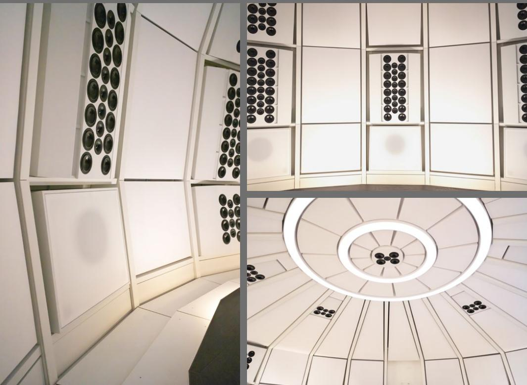
Die 24-teilige Rippen-Kuppel-Konstruktion von THE LAB stellt ein Gestellsystem für die integrierten Lautsprecher und Absorber dar. Alles ist voneinander entkoppelt und durchkomponiert. Die Lautsprecher sind von Jürgen Strauss entwickelte Linienquellen, denn wegen der großen Abhördistanz von rund fünf Metern kamen Punktschallquellen nicht mehr in Frage
